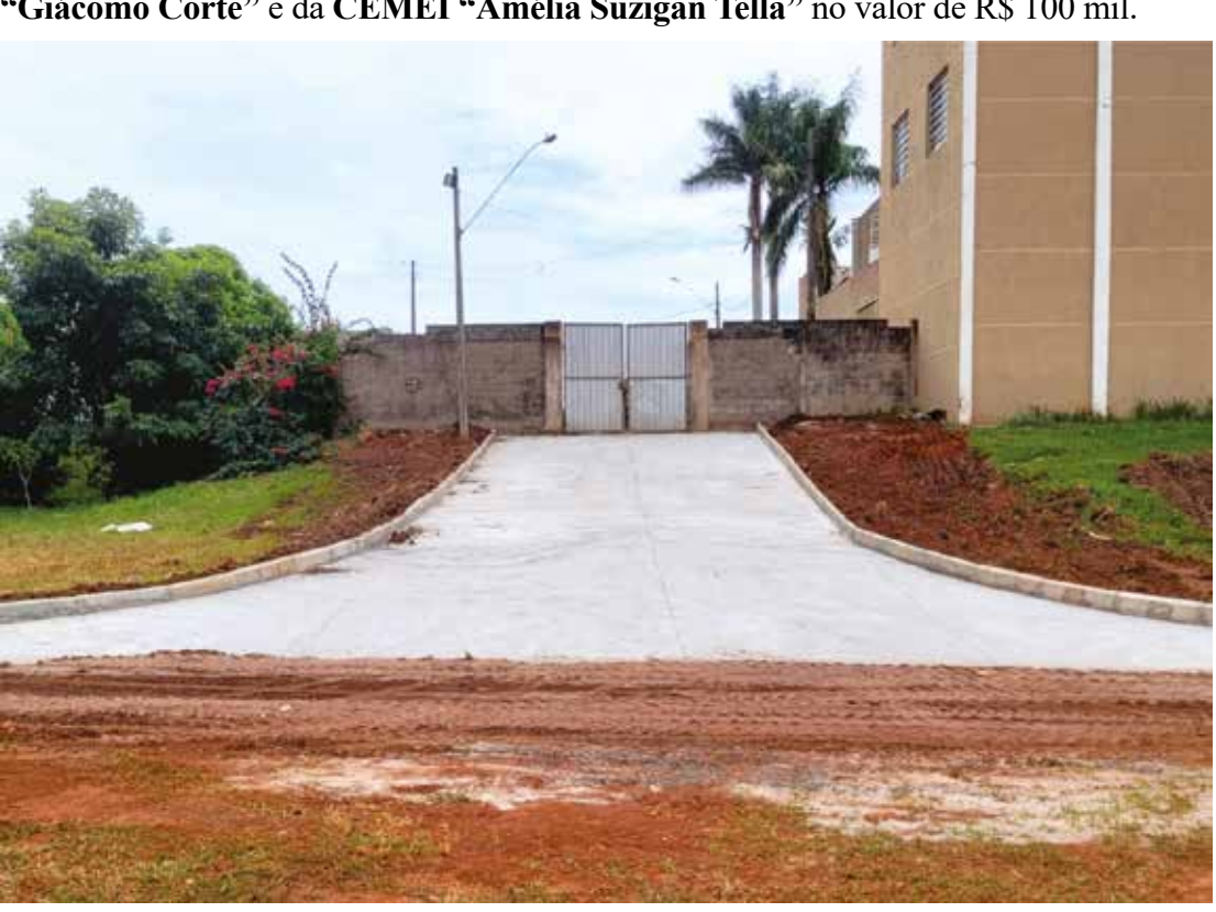
Ordem de serviço para construção de rampa no Ginásio Poliesportivo “Rei Pelé” na entrada da Rua Sebastião Gomes, para facilitar o acesso de PCDs, por meio de emenda impositiva.
