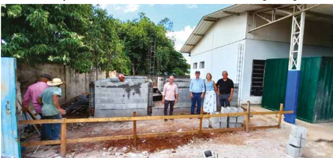
Início da ampliação e reforma da creche “Maria Inês Pereira da Silva Lourenço” , no valor de R$ 1.599.000,00, conquistado durante a gestão Vando e Ângela Caleffi.
